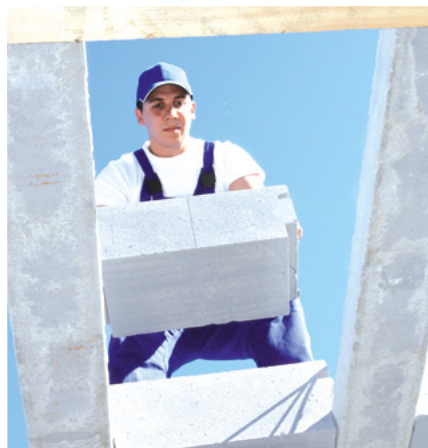
Ukládání stropních vložek
