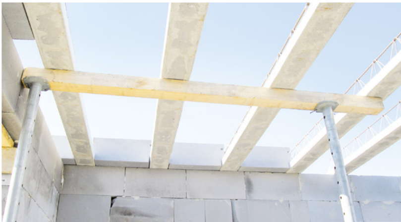
Podpěření stropních nosníků
